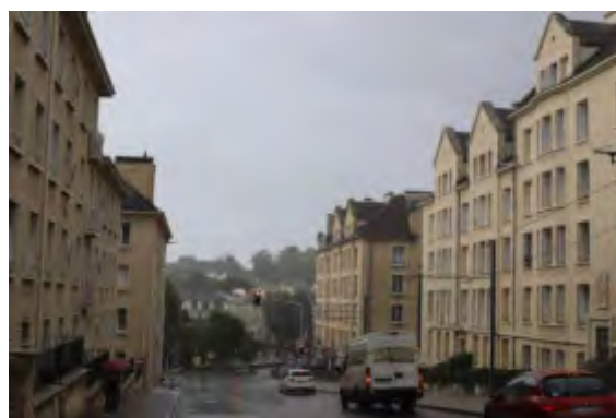
Figure 203 : Collectifs rue du Gaillon à Caen
