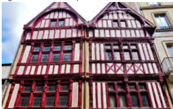
Figure 213 : Maisons à pans de bois, rue Saint-Pierre
