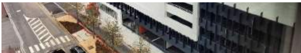
Nouveau parcotrain en construction à côté du parvis nord de la gare de Caen
