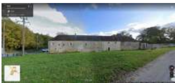
Fleury-sur-Orne, corps de ferme divisé en logements individuels, Street-View 2011-2021
