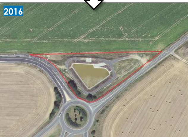
Création d'un bassin de rétention des eaux pluviales = Environ 0,7 ha Thue et Mue
